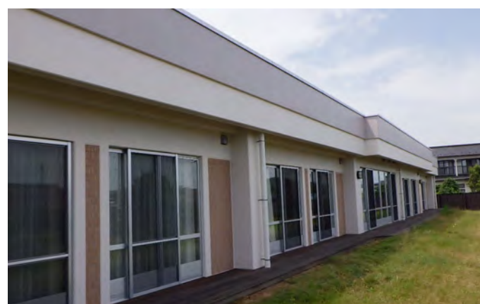
建物外部改修工事
