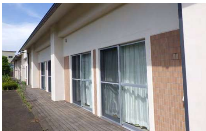
建物外部改修工事
