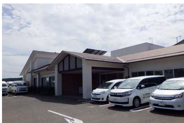
建物外部改修工事
