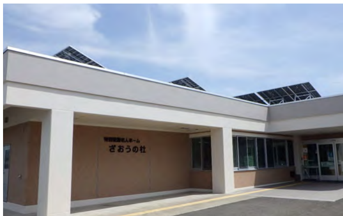
建物外部改修工事
