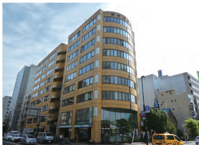
外壁改修工事
