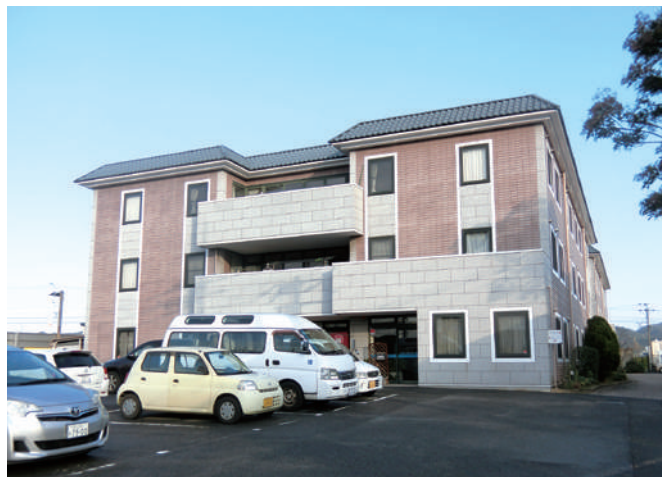
外壁改修工事
