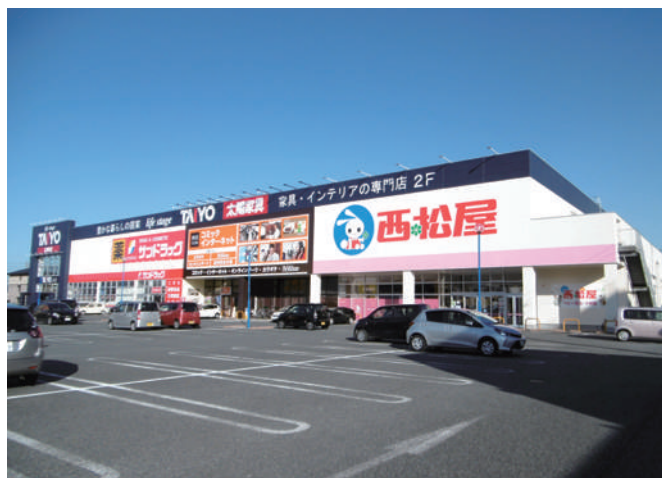
外壁改修工事
